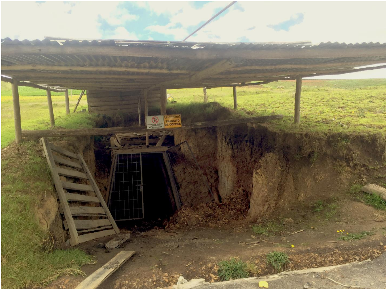
Imagen 2- entrada a la bocamina.
